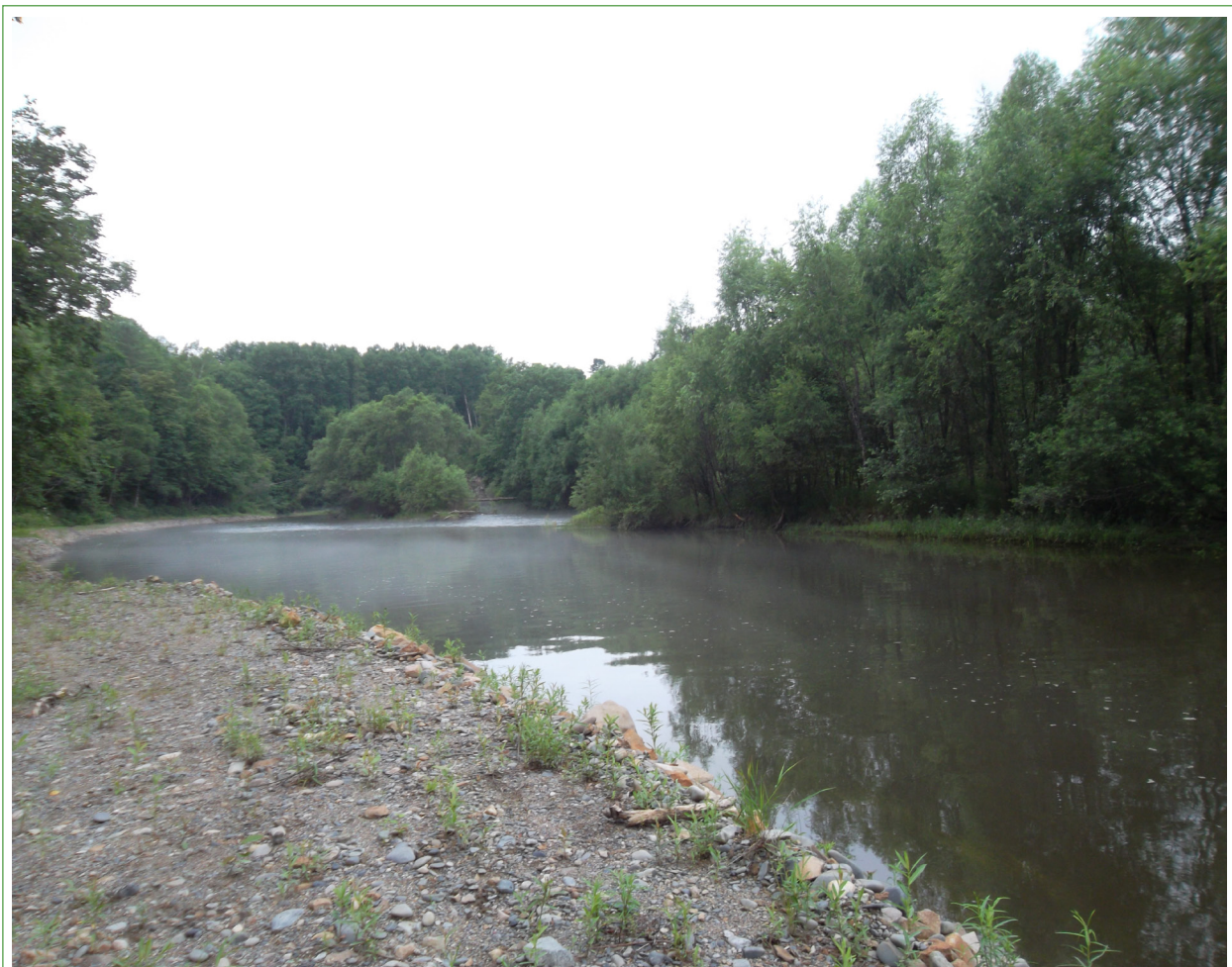
Рис. 3. Протока Бира р. Анюй в районе отсыпки береговой линии и части русла
